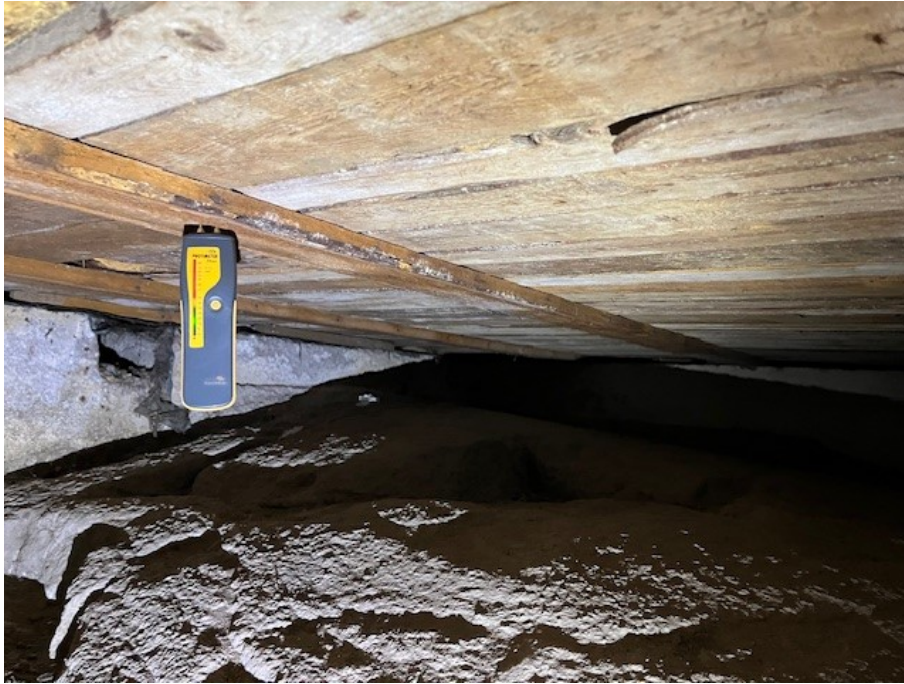
Fuktmätning i torpargrunden.
